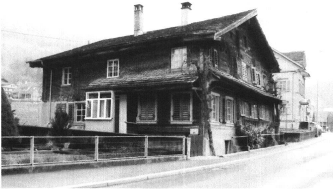
Abb. 8: Steinen, Haus Schürmann, Schwyzerstrasse 9. Das an der Strasse von Steinen nach Schwyz liegende Gebäude mit wesentlichen Bauteilen aus dem 13. Jahrhundert befand sich vor der Restaurierung in einem recht verfallenen Zustand.
