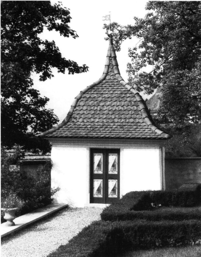
Abb. 2: Schwyz, Ital Reding-Haus, Gartenhäuschen. Eckpavillons gehören zu den wesentlichen Merkmalen der Schwyzer Herrschaftsgärten des 17. und 18. Jahrhunderts. Letztlich können diese wie die in die Mauer eingelassenen Schiesscharten als Architekturzitate aus der Burgenarchitektur angesehen werden.
