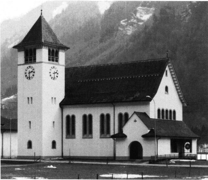
Abb. 6: Muotathal, Kirche Ried. Die Gestaltung des Äusseren verrät den Übergang von Historismus zur Moderne. In die strenge Gesamtgestaltung sind Gestaltungselemente des späten Historismus integriert.
