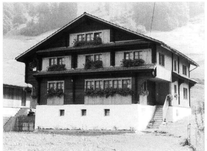
Abb. 7: Muotathal, Bauernhaus Oberschachen. Das im Giebelfeld 1819 datierte Bauernhaus gehört zu den späten Vertretern des Tätschdachhauses im Kanton Schwyz. Traditionell sind die Lauben, wobei die westseitige in die Strickkonstruktion miteinbezogen ist und somit von Anfang an bewohnt war. Zur überlieferten Formensprache gehören auch die Reihenfenster und Ziehläden.
