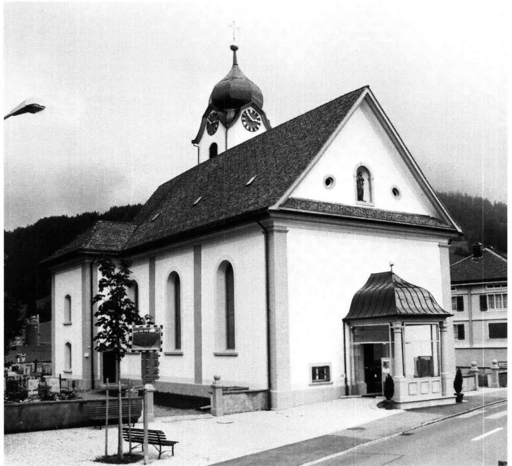
Abb. 20: Einsiedeln, Kirche Euthal. Das Äussere der Kirche wurde anhand des Befundes neu gestrichen. Die differenzierte grau-blaue Fassung geht auf die Zeit des Turmbaus zurück.
