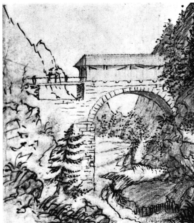
Abb. 2: Die Steinene Brücke mit der Holzbedachung, wie sie bis zum Juni 1799 ausgesehen haben mag. Zeichnung in Joseph Thomas Fassbinds «Religionsgeschichte», Bd. VI., S. 243.
