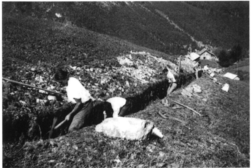
Abb. 2-Abb. 4: Der Bau des Elektrizitätswerks Bisisthal war mit viel Handarbeit verbunden.
