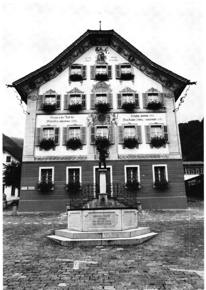
Abb. 5: Das «Alte Rathaus» von Gersau, 1745 erbaut und 1982/83 umfas- send restauriert, mit dem Schiffmeister Balz-Brunnen.
