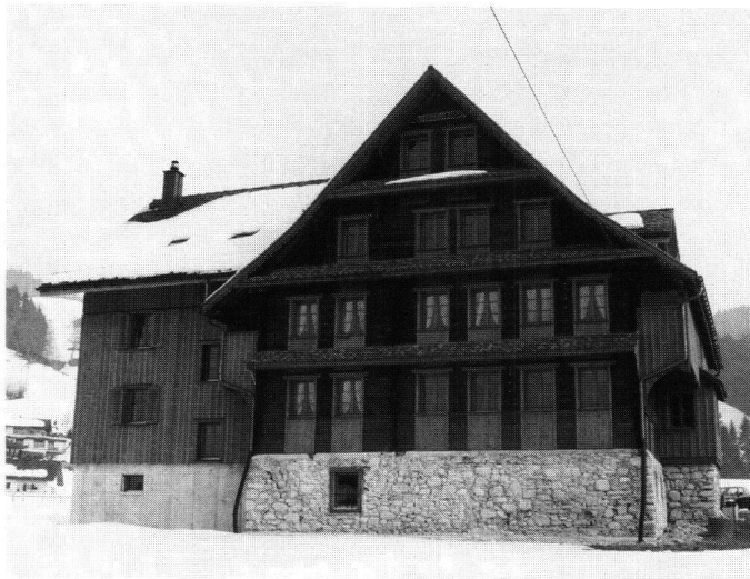
Abb. 1: Rothenthurm, Haus Schuler, Chilleren. Das 1809 datierte grosse Bauernhaus vereint barocke und klassizistische Elemente. Das Gesamterscheinungsbild mit steilem, geknicktem Giebeldach und seitlichen Lauben entspricht der Bautradition des 18. Jahrhunderts, während die Fenstereinteilung bereits dem Klassizismus zuzuordnen ist. Traditionell sind die vorgehängten Ziehläden. Noch fehlt der Sockelputz.
