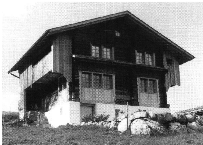
Abb. 12: Schübelbach, Bauernhaus Buck, Buttikon. Das kleine Holzhaus gehört zu den wenigen Tätschdachhäusern, die in der March erhalten geblieben sind. Trotzdem besitzt es aber für die March typische Elemente wie die massiv gemauerte Wetterseite und reich ausgebildete Seitenbärte bei den Ziehläden.
