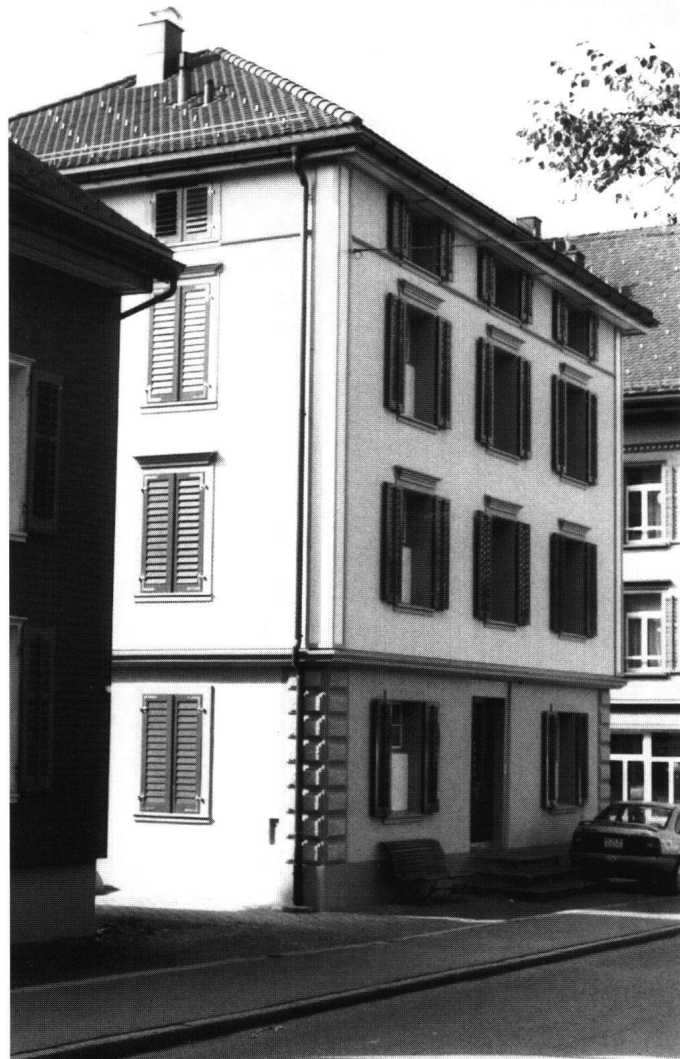
Abb. 18: Einsiedeln, Lärche, Eisenbahnstrasse. Die strenge symmetrische Fassadengestaltung des quadratischen Gebäudes unterstreicht dessen wichtige Funktion als Eckpunkt der Quartierplanung von 1875.
