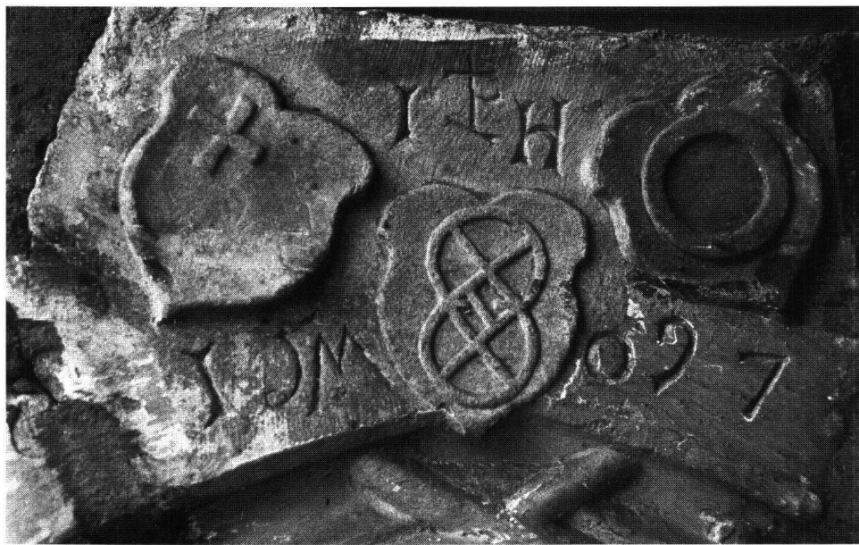
Abb. 11: Galgenen, Haus Kürzi. Der 1597 datierte Schlussstein des gotischen Portals beim Saalanbau.
