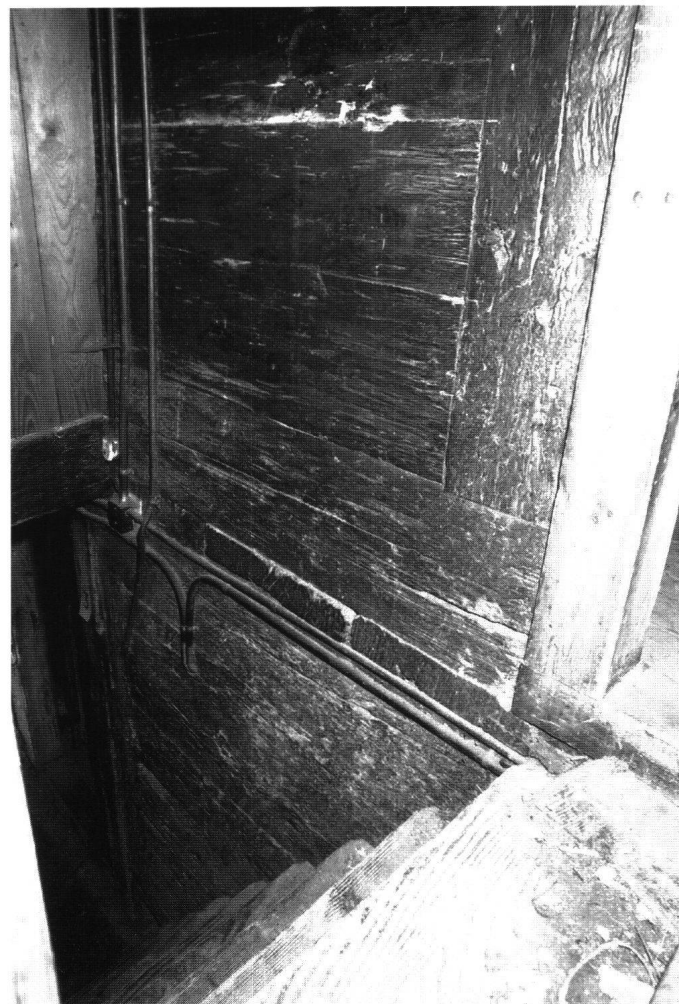
Abb. 16: Zweites Obergeschoss, Trennwand. Erkennbar sind Decken-/Bodenbohlen sowie ein ursprünglicher Türpfosten (Aufnahme 1997).
