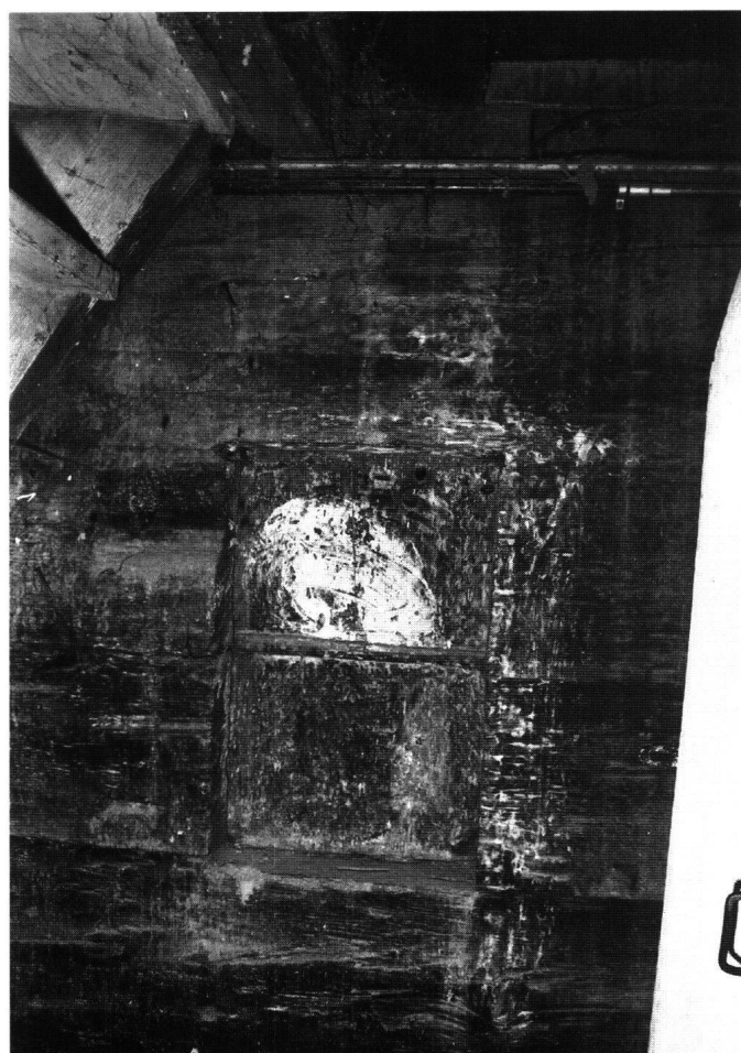
Abb. 13: Erstes Obergeschoss, Trennwand. Öffnung und Wandspuren eines einstmaligen Wandschranks, Westseite (Aufnahme 1997).
