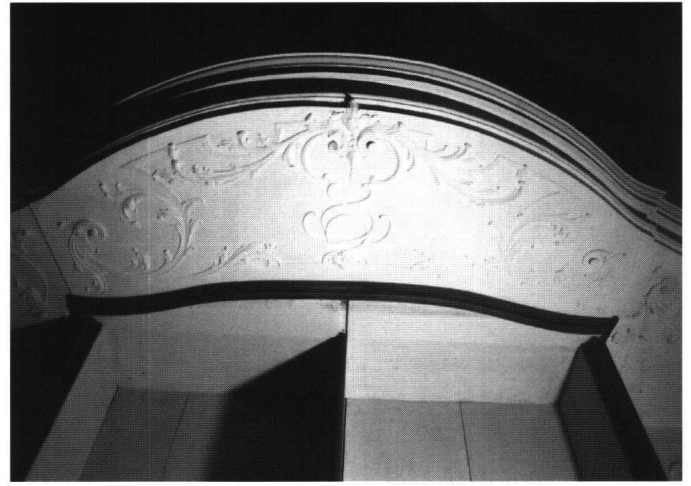
Abb. 20 + 21: Einsiedeln, Kloster, Bibliothek . Untersicht der Galerie. Der Vorzustand zeigt die starken Beschädigungen durch die Montage der neuen Büchergestelle im 19. Jahrhundert. Die Stuckaturen wurden anhand der erhaltenen plastischen Reste und der Ritzlinien ergänzt.
