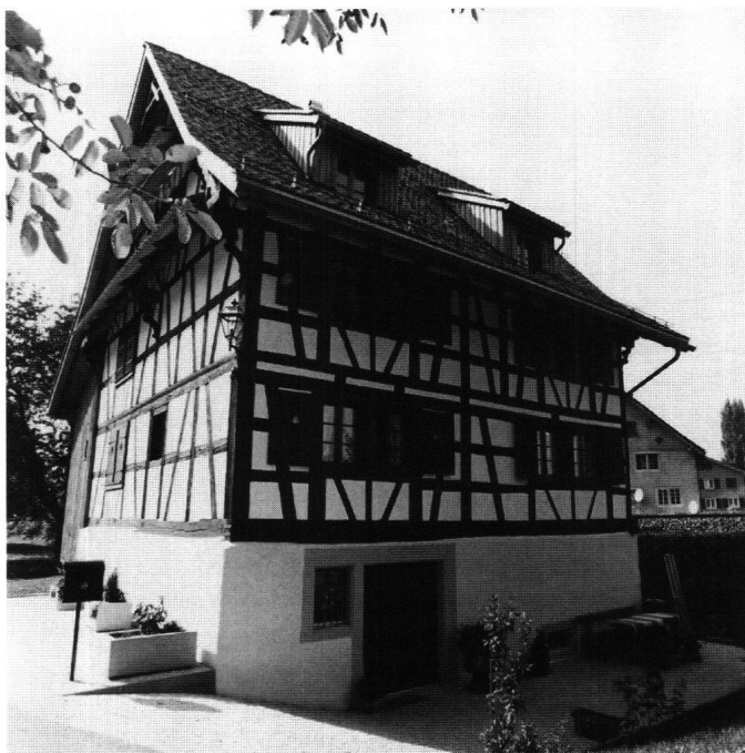
Abb. 28: Freienbach, Bäch, Haus Pfyfferweg 13. Das am Portal 1761 datierte Gebäude ist als einfache Fachwerkkonstruktion ausgeführt. Ab dem 18. Jahrhundert finden wir diese Konstruktionsart bei zahlreichen Bauten auch auf schwyzerischem Gebiet am oberen Zürichsee.
