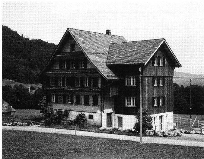
Abb. 11: Vorderthal, Schwändihof. Das Bauernhaus gehört zu den grossen Märcbler Häusern, von denen viele ab der zweiten Hälfte des 18. Jahrhunderts entstanden sind. Der neue Anbau dient der Erschliessung des Gebäudes.
