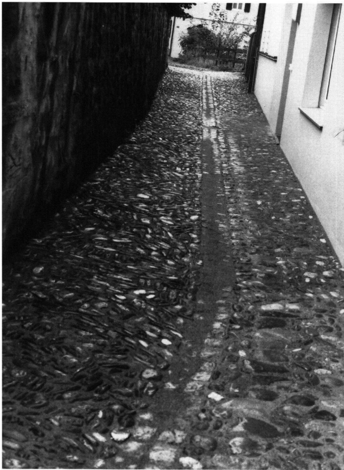
Abb. 4: Schwyz, Pflasterung Reichsgasse. Katzenkopfpflasterungen sind in Schwyz selten geworden. Gut zu erkennen sind die unregelmässige Verlegungsart der Steine sowie die ausgeprägte Mittelrinne.
