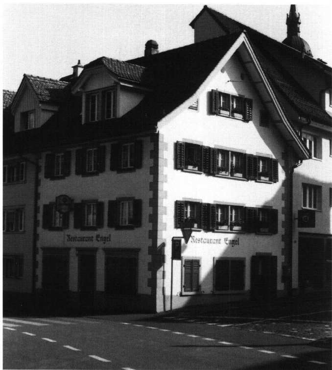
Abb. 7: Arth, Haus Engel. Der Engel besitzt am Eckpunkt Gotthardstrasse-Rathausplatz einen sehr hohen Stellenwert, der durch die aufgemalten, nach Befund rekonstruierten Eckquader betont wird.
