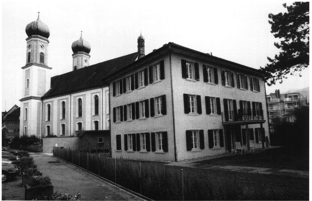
Abb. 10: Lachen, Pfarrhaus. Das seit 1935 als Pfarrhaus benutzte Gebäude ist ein streng gegliederter klassizistischer Baukörper. Die Fassadengestaltung wurde anhand von ähnlichen Objekten rekonstruiert, da am Gebäude selber kein Befund mehr vorhanden war.
