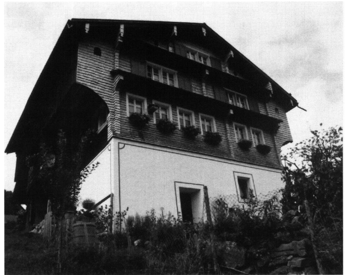
Abb. 6: Schwyz, Aufiberg, Bauernhaus Urmis. Wegen der starken Hanglage ist die Sockelmauer des Bauernhauses Urmis sehr hoch. An den Mauerecken ist die einfache sgraffitoähnliche Dekoration des späten 18. Jahrhunderts gut zu erkennen.
