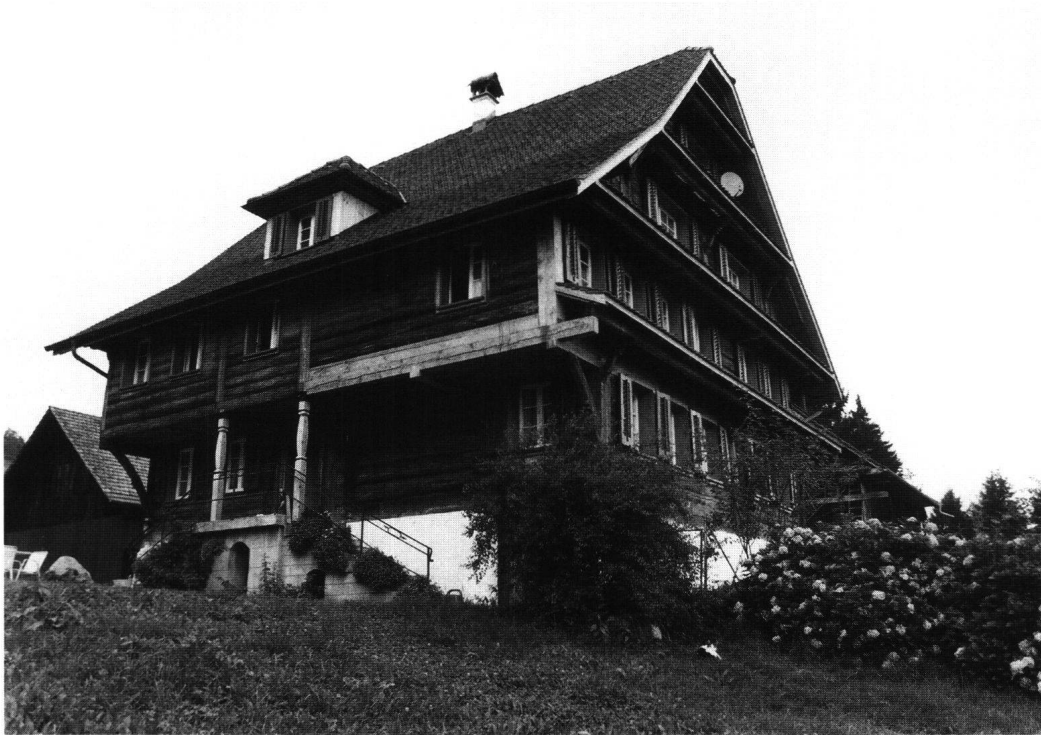
Abb. 27: Küssnacht. Bauernhaus Hintertannbüel. Das grosse Bauernhaus entstand in zwei Etappen, wobei der als Strickbau ausgeführte ältere Bauteil nicht datiert werden konnte. Hingegen verweisen stilistische Merkmale die Erweiterung des Kernbaus als Bohlen-Ständerkonstruktion in luzernerischer Art in die zweite Hälfte des 18. Jahrhunderts.
