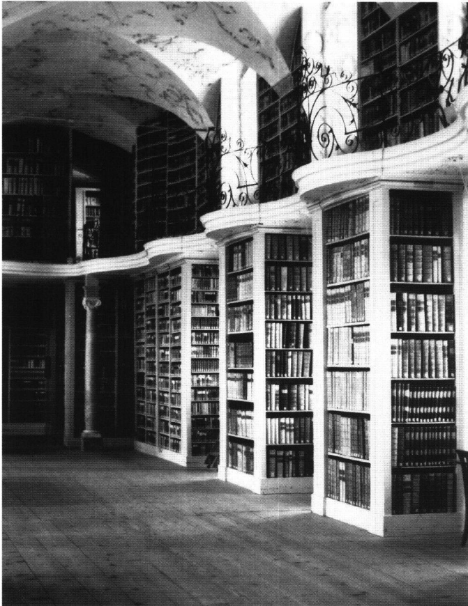
Abb. 13: Einsiedeln, Kloster, Bibliothek. Der Raum vor der Restaurierung. Unterhalb der Galerie stehen noch die Büchergestelle des 19. Jahrhunderts, die weiter in den Raum vorragen als die originalen Gestelle. An der Rückwand sind die ursprünglich unter der Galerie platzierten originalen Gestelle sichtbar.
