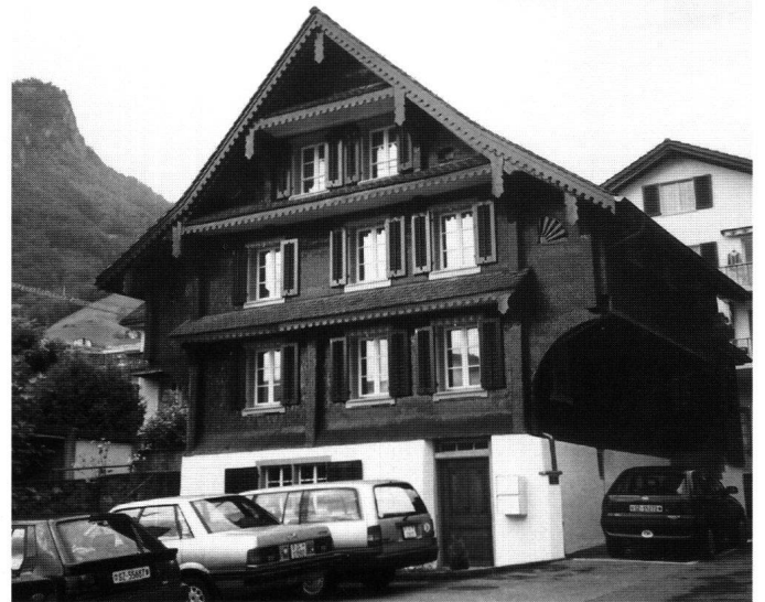
Abb. 9: Gersau, Pfarrhelferhaus. Das Holzhaus wurde im 17. Jahrhundert erbaut. Umgebaut wurde es im Jahr 1779 sowie um die Mitte des 19. Jahrhunderts. Zu diesem Zeitpunkt wurde das Gebäude verschindelt und oxsenblutrot bemalt.
