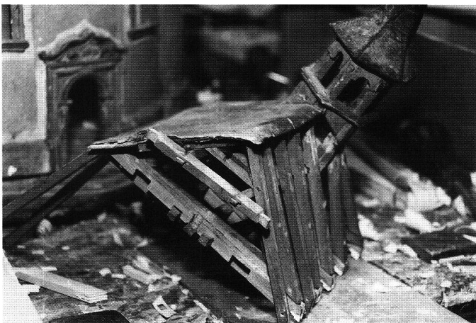
Abb. 1 und 2: Zustand des Modells vor der Restaurierung auf dem Arbeitstisch des Restaurators. Gut zu erkennen sind die losen Teile des Dachstuhls sowie die erhaltenen Reste des Bedachungsmaterials.
