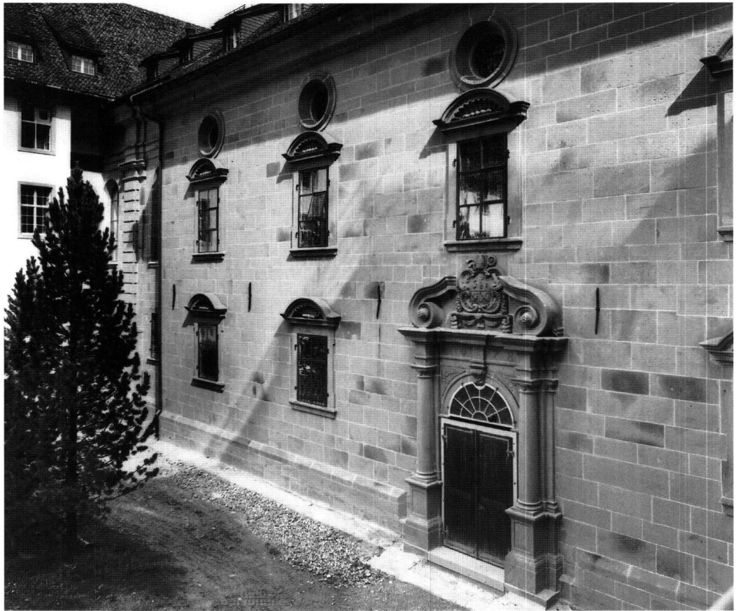
Abb. 25: Einsiedeln, Beichtkirche. Die Westfassade der Beichtkirche war bis zum Bau des neuen Klosters vom Platz her einzusehen. Deshalb ist diese im Gegensatz zur Ostfassade vollständig in Sandstein ausgeführt. Die untere Fensterreihe rechts gehört zum Beichthaus, die darüberliegende zur Studentenkapelle, und die beiden Fensterreihen links führen in die Magdalenenkapelle.
