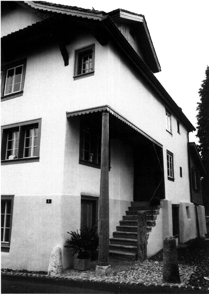
Abb. 13: Schwyz, Haus Alte Gasse Nr. 6, Ibach. Der Hauszugang führt in traditioneller Art unter der Laube direkt ins erste Obergeschoss.
