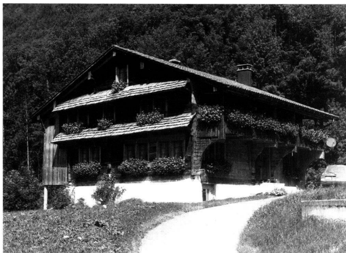
Abb. 19: Muotathal, Bauernhaus Husmatt, Ried. Das zwischen 1551 und 1554 erbaute Bauernhaus besass ursprünglich keine Klebedächer. Diese kamen in unserer Gegend im Verlauf des 16. Jahrhunderts bei Herren- und Bürgerhäusern in Mode. Erst im Verlauf des 17. Jahrhunderts wurden sie zu einem typischen Merkmal der Bauernhäuser.
