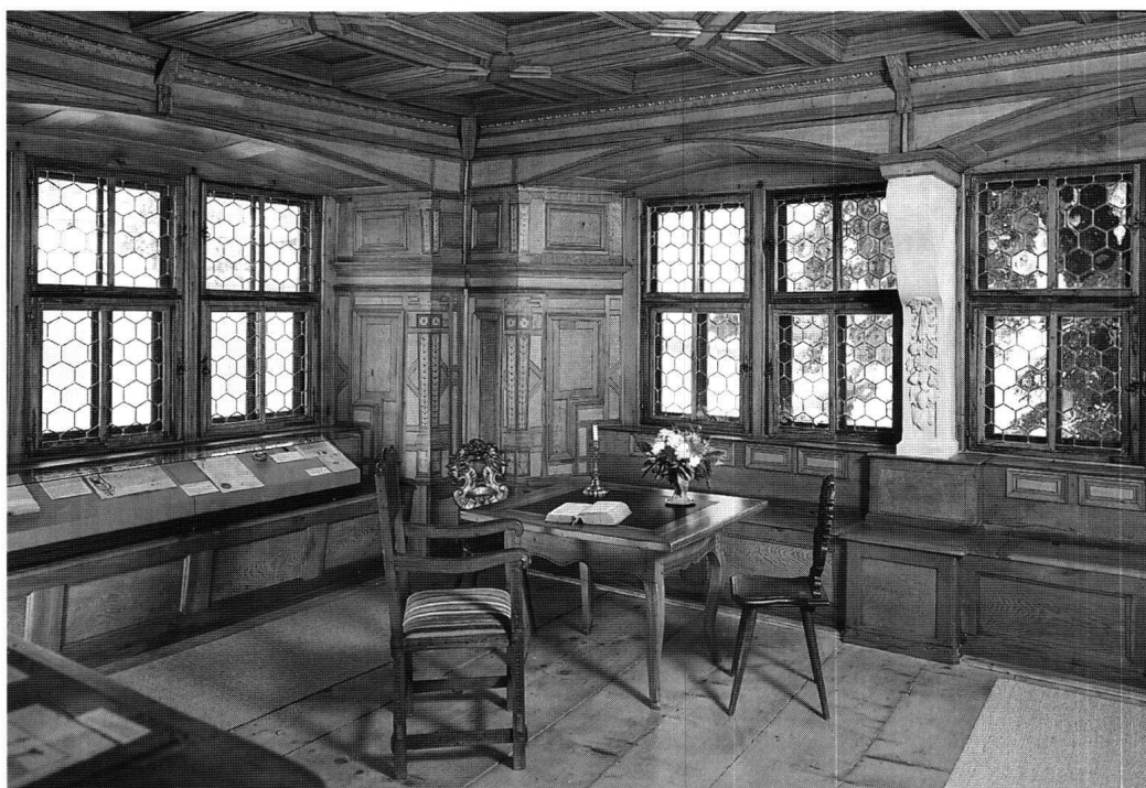
Abb. 1: Schwyz, Ital Reding-Haus, Kleiner Saal. Nach der Entfernung der obersten Firnissschicht wird die Differenzierung der verschiedenen Holzarten deutlich sichtbar. Die Truhenbänke sind unter Verwendung der originalen Vorderfronten wiederhergestellt. Der einfache Bretterboden gehört zur Originalsubstanz.
