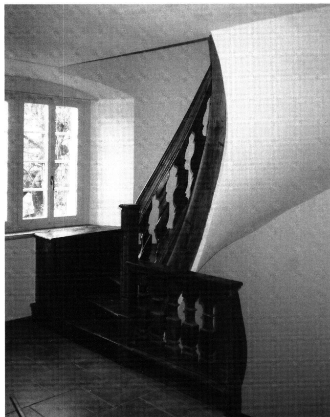
Abb. 6: Schwyz, Steinstöckli. Die gewundene Holztreppe stammt aus der Bauzeit des Hauses. Im 18. Jahrhundert wurden die reich profilierten Baluster aufgesetzt und die Treppenuntersicht vergipst.
