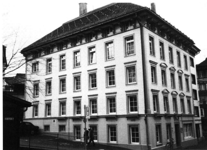
Abb. 13: Einsiedeln, Haus Raben, Schwanenstrasse 42. Das städtisch anmutende Gebäude ist mit Ausnahme des Mauersockels in Holz errichtet, farblich jedoch einem Steinbau angeglichen.
