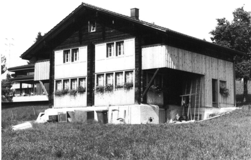
Abb. 9: Tuggen, Haus Bollenbergstrasse 14. Anhand der axialsymmetrischen Fenstereinteilung lässt sich ablesen, dass das kleine Haus von Anfang an in zwei Hälften aufgeteilt war, die unabhängig von zwei Familien bewohnt wurden. Die Vertäferung an der Hauptfront ist eine Zutat des 18. Jahrhunderts.
