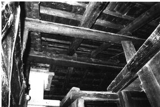
Abb. 21: Dachuntersicht mit sekundären Kammereinbauten, Ansicht gegen Südosten.
