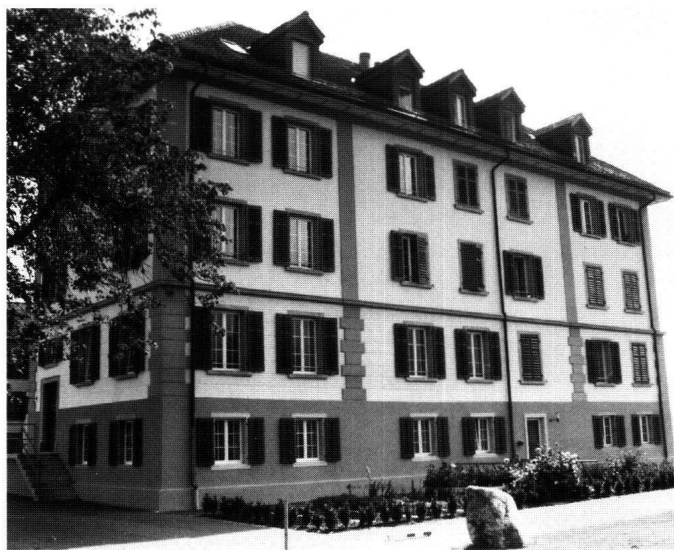
Abb. 7: Steinen, Alters- und Pflegezentrum Au. Durch den Abbruch des erst im Jahr 1978 vor der Hauptfassade errichteten Speisesaals steht der kubische Baukörper auf drei Seiten wiederum frei.
