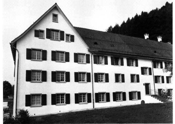
Abb. 22: Einsiedeln, Kloster in der Au, Trachslau. Der rekonstruierte Giebel auf der Nordfassade. Dieser bildet das Pendant zum original erhaltenen Giebel auf dem nordwestlichen Eckkrisalit.
