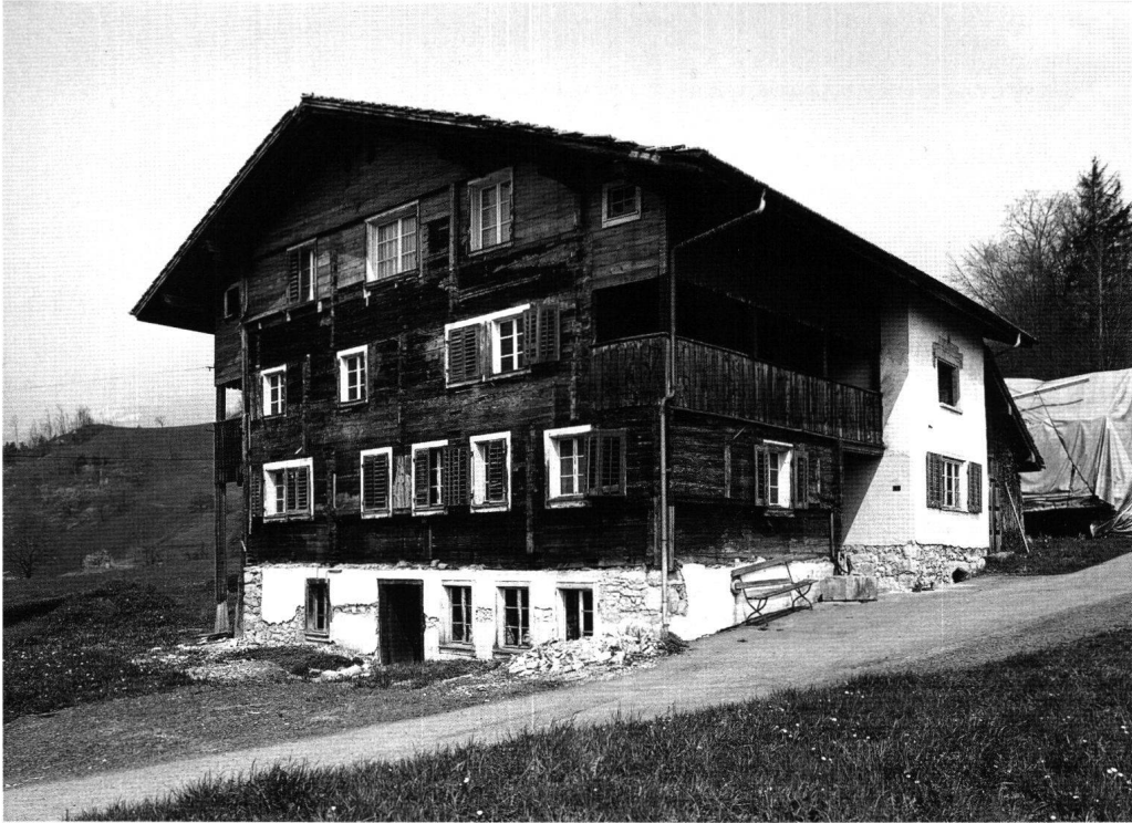
Abb. 8: Das Köplihaus nach Entfernen der Eternitschindeln, Ansicht gegen Nordwesten (Aufnahme Januar 2004).
