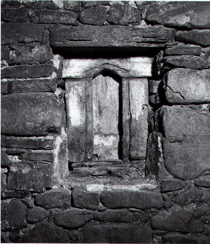
Abb. 26: Erdgeschoss/Kellerraum 0.2, Westwand. Fensteröffnung mit hölzernen Rahmen.
