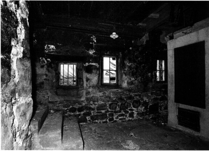
Abb. 30: Erstes Obergeschoss, Küche 1.8, Ansicht gegen Norden.
