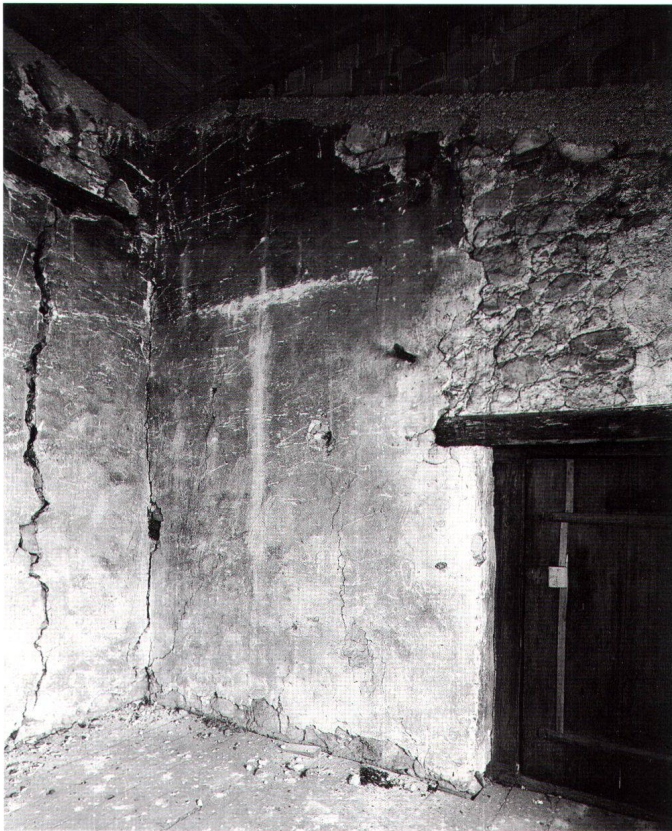
Abb. 38: Zweites Obergeschoss, Kammer 2.7, Ansicht gegen Südosten.
