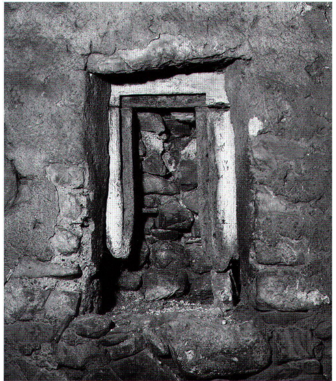
Abb. 27: Erdgeschoss/Kellerraum 0.2, Binnenwand. Fensteröffnung mit hölzernen Rahmen.
