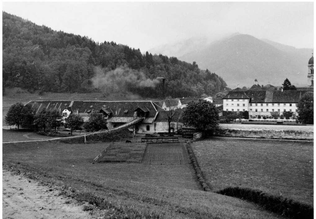
Abb. 32: Ansicht Ökonomiegebäude mit rauchendem Kamin, undatiert.
