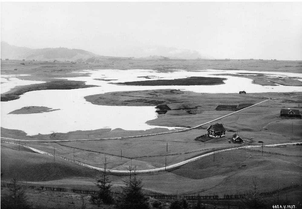
Abb. 43: Am 1. Mai wurde mit der Stauung begonnen. Bild vom 4. Mai 1937.
