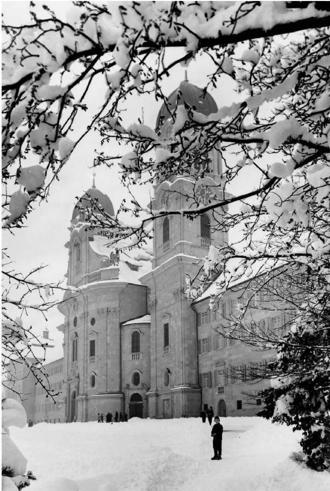
Abb. 34: Kirchenfassade, undatiert (Bild: O. Baur, Stella-Photo, Einsiedeln)
