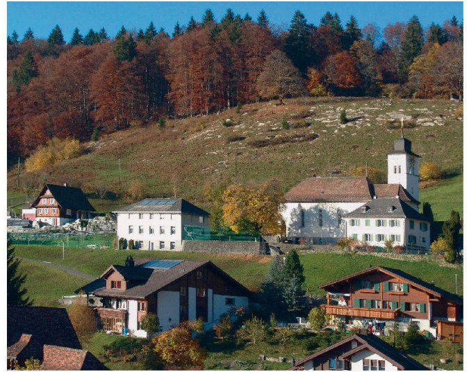
Das neue Dorf Innerthal ist eine künstlich angelegte Siedlung am Gugelberg. Aus der heute beträchtlich erweiterten Siedlung stechen die drei 1923 als Gebäudegruppe konzipierten Häuser heraus: Kirche, Pfarrhaus und Schulhaus.
