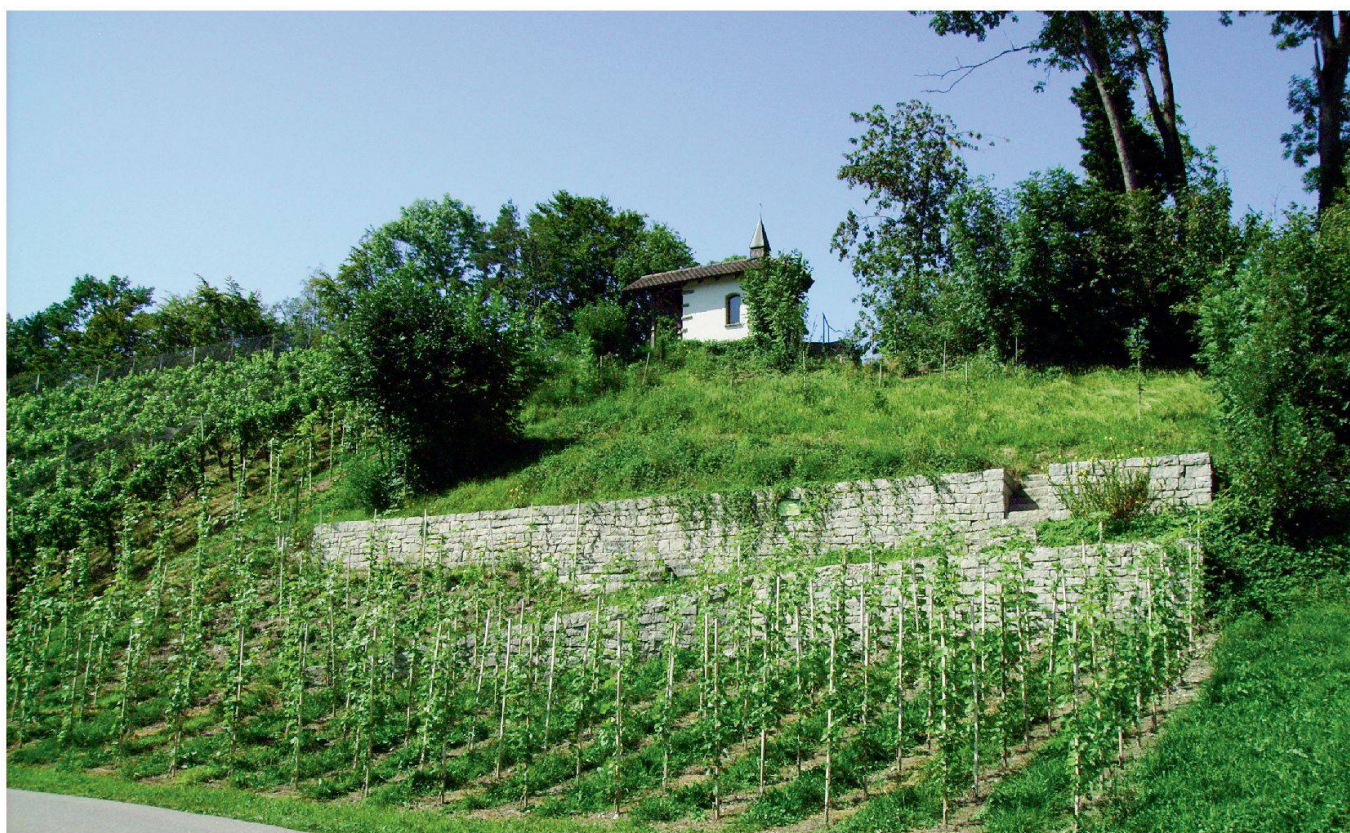
Das «Stocker-Chappeli» in Freienbach – ein beschaulicher Ruheplatz am Leutschen-Rebpfad.
