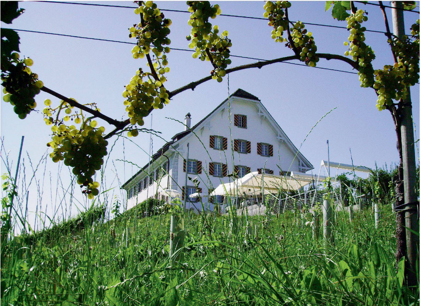
Leutschenhaus Freienbach – ein stattlicher Barockbau in der Reblandschaft.
