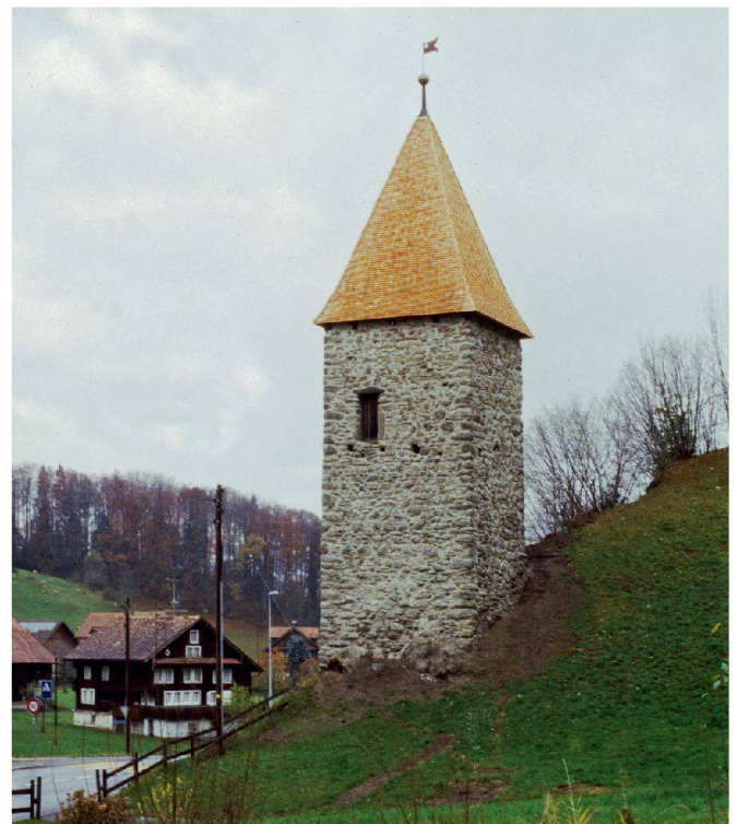
Abb. 1: Sattel SZ, Morgarten, Letziturm 2007.
