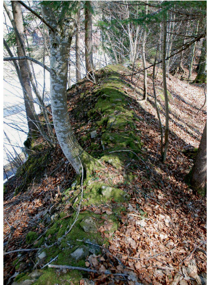
Abb. 26: Sattel SZ, Morgarten, Letzimauer 2009. Mauerreste entlang der Oberkante der steil gegen Norden abfallenden Fluh; von WSW.
