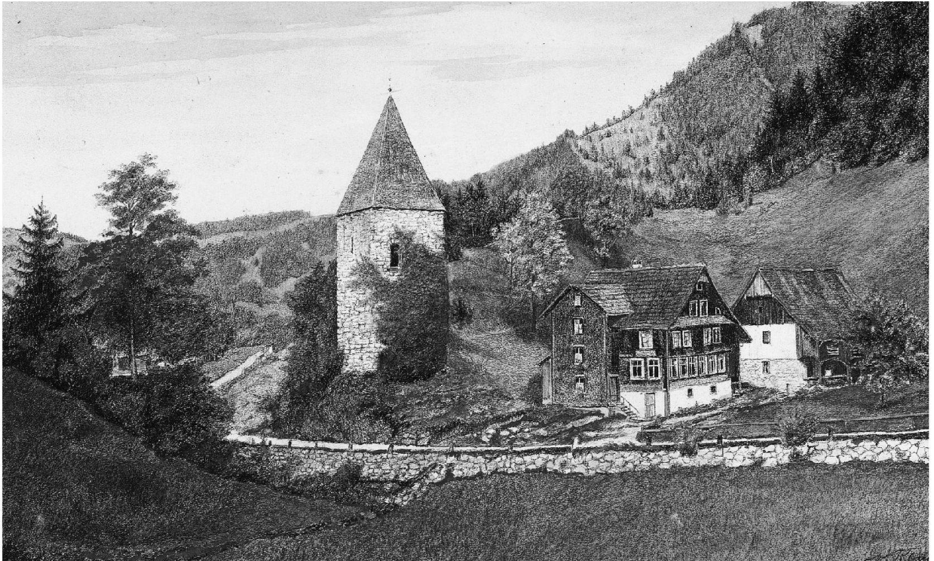
Abb. 4: Gasthof zum «Turm», abgebrannt im Dezember 1916. Damals griffen die Flammen auch auf Dach und Gebälk des Letziturms über, der in der Folge völlig ausbrannte. W. Klaus, Der Letziturm von Schorno am Morgarten, erbaut anno 1322, Pastellkreide, 1918.
