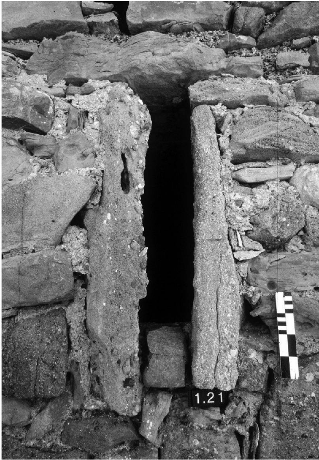
Abb. 16: Sattel SZ, Morgarten, Letziturm. Schartenfenster mit zwei hochkant gestellten Sandsteinplatten als Gewände auf der Nordseite des 2. Obergeschosses; von N.
