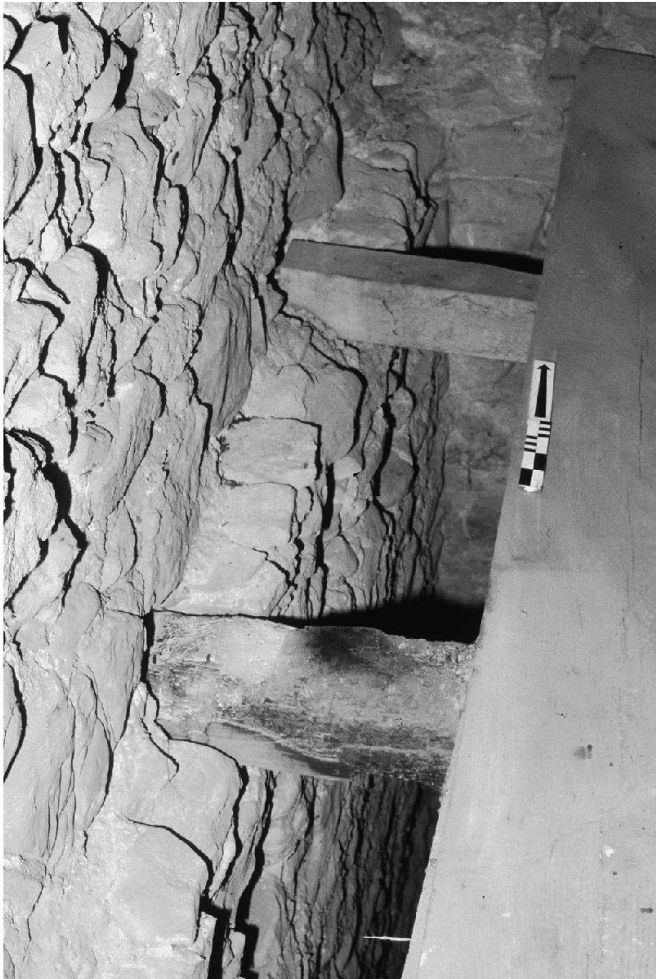
Abb. 9: Sattel SZ, Morgarten, Letziturm. Mauerabsatz der Westwand des 1. Obergeschosses; von S. Die zwei Deckenbalken stammen von einer Reparatur im 20. Jahrhundert. Der vordere, angesetzte war vermutlich Teil des Holzwerks, das 1916 verbrannt ist.
