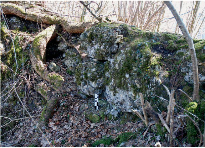
Abb. 23: Sattel SZ, Morgarten, Letzimauer 2009. Reste des feindseitigen Mauermantels aus grossen Nagelfluhbrocken in einem Abschnitt der Letzimauer östlich von 4; von WNW.
