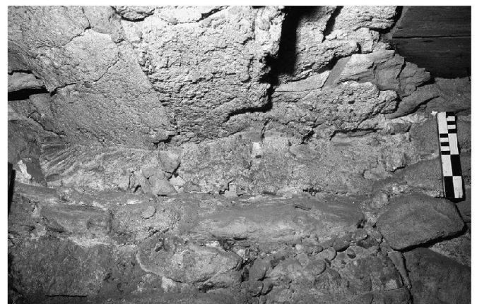
Abb. 12: Sattel SZ, Morgarten, Letziturm. Mörtelnegative der herausgerissenen hölzernen Sturzbalken hinter der Türe des Hocheingangs; von E.
