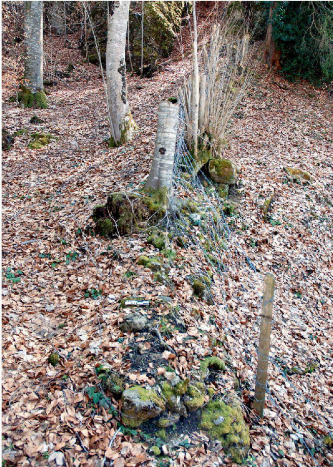
Abb. 25: Sattel SZ, Morgarten, Letzimauer 2009. Im steilen Gelände gut sichtbare Reste der Traverse G; von N.
