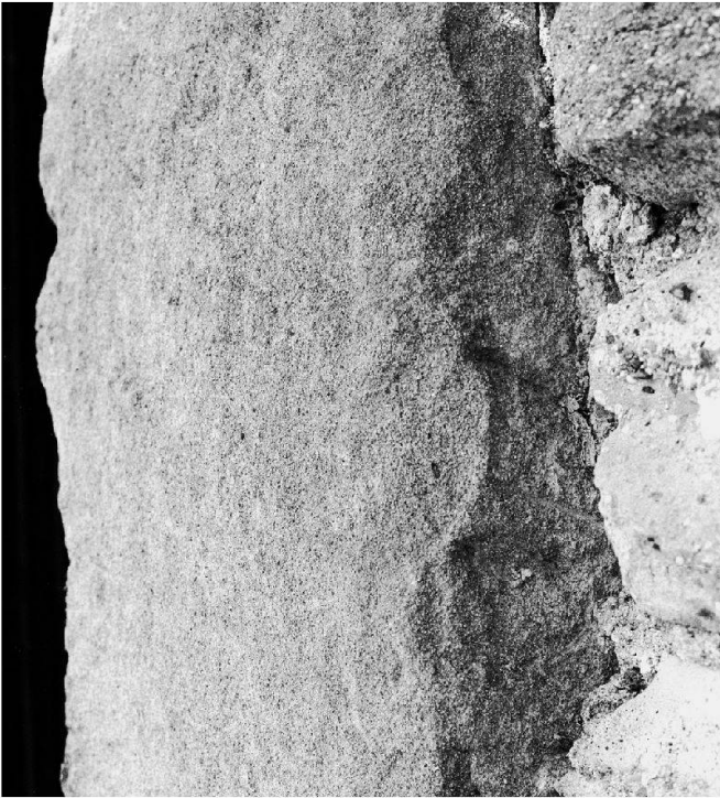
Abb. 11: Sattel SZ, Morgarten, Letziturm. Auffällige Bruchkante von der Steinbearbeitung am untersten Stein des östlichen Türpfostens des Hocheingangs; von SE.
