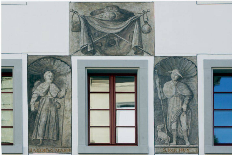
Abb. 6: Der Pestheilige Rochus und der Pilgerheilige Jakobus an der Aussenwand des 1751/52 erbauten Spittels (heute Gemeindehaus) in Schwyz. Die beiden Heiligen deuten auf die Multifunktionalität des als Spital genutzten Gebäudes hin: Zum einen wurden hier Kranke behandelt, zum anderen wurden durchreisende Pilger, aber auch auswärtige Handwerker, beherbergt. Die Verwendung des Pestheiligen Rochus als Sinnbild eines Krankenpatrons selbst in der Mitte des 18. Jahrhunderts deutet auf die memoriale Bedeutung der Pest hin; denn die Seuche war in Westeuropa weitgehend schon seit Jahrzehnten nicht mehr aufgetreten und hatte in Schwyz selber letztmals in der Mitte der 1630er-Jahre gewütet.
