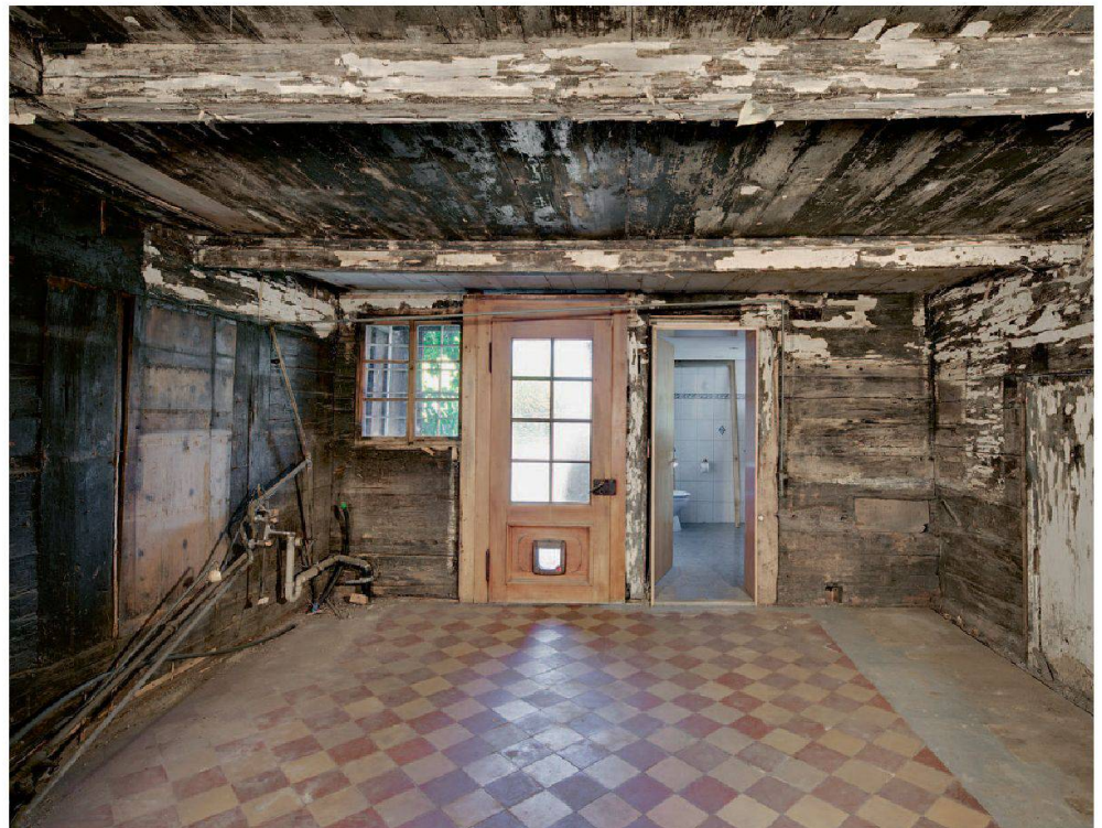
Abb. 7: Gang- und Küchenbereich (1.6) gegen Westen, mit den überformten Türöffnungen des westlichen Hauseinganges (links) und des Abortes (rechts).
