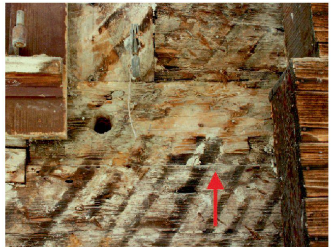
Abb. 5: Fensterbrüstungsbalken mit Würfel-Zierfries (Pfeil).
