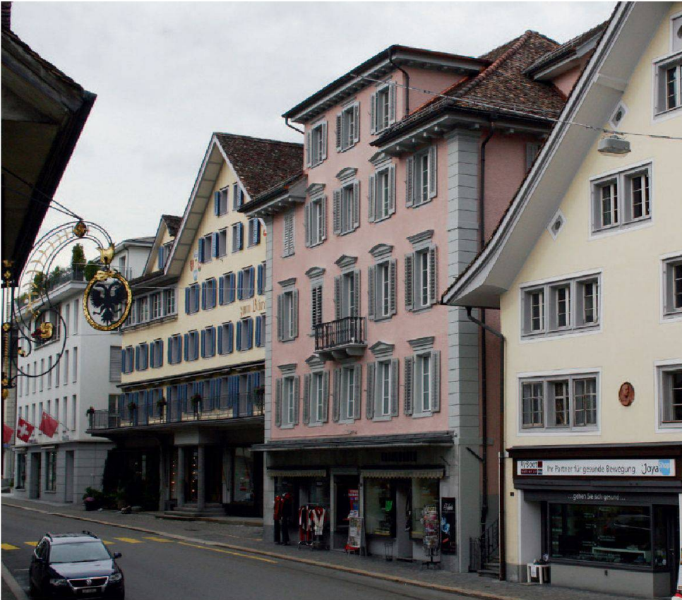
Abb. 8: Schwyz, Herrengasse 8, Triner. Der gut proportionierte Biedermeierbau setzt einen starken Akzent in der nördlichen Häuserzeile an der Herrengasse.
