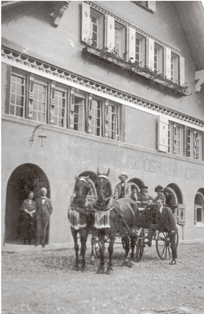
Abb. 5: Mit dem Strassen- und Wasserkraftwerkbau sowie dem Stausee entstanden im Wägital neue grosszügige Wirtshäuser. Die Aufnahme zeigt das 1925 eröffnete Gasthaus & Post neu Innerthal, das heutige Gasthaus Stausee. Im Torbogen steht August Spiess, der erste Pächter des Betriebs. Als Bezirksammann der March war er ein grosser Förderer des Kraftwerkbbaus.
