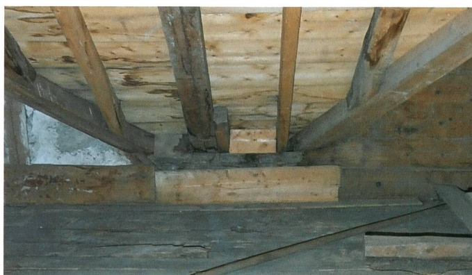
Abb. 15: Erstes Geschoss des Dachraumes, Giebelwände der Phase 2 in Blocktechnik (rechts) und der Phase 4 in Fachwerktechnik (links).
