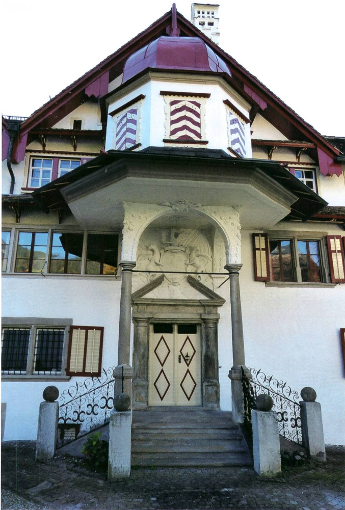
Abb. 9: Hauptportal an der Nordfassade.
