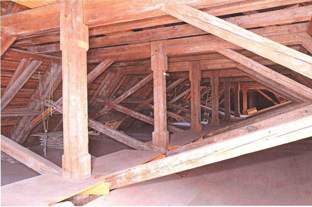
Abb. 13: Näfels GL, Pfarrkirche St. Hilarius, Aufrichte 1779 oder 1780, Übersicht über das Langhausdachwerk von Südwesten.
