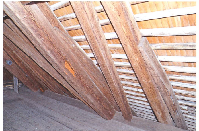
Abb. 7: Entlebuch LU, Pfarrkirche St. Martin, Aufrichte 30. September 1778, Baumeister Niklaus Purtschert, Detail der seitlich an die Sparren angenagelten Aufschieblinge.
