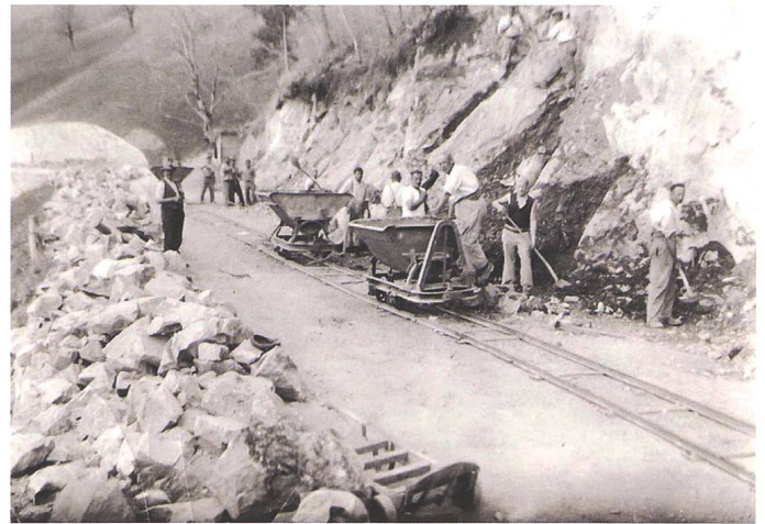
Abb. 5: Verbreiterung der Strasse von Gersau nach Vitznau, 1938. An der Finanzierung der ersten Strassenverbindung nach Vitznau 1885–1886 hatten sich der Bund, der vorgängig den Bau der Axenstrasse subventioniert hatte, sowie Kanton, Bezirk, Genossen-Korporation und Private beteiligt.
