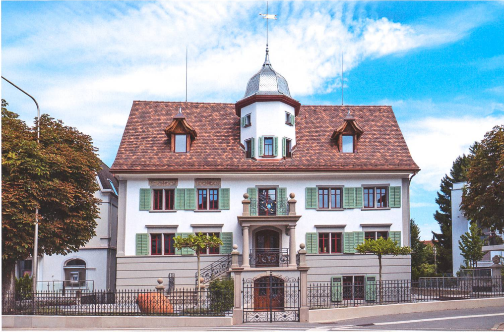
Abb. 8: Lachen, Schössli, Südfassade mit Treppenvorbau, wohl aus dem späten 19. Jahrhundert.
