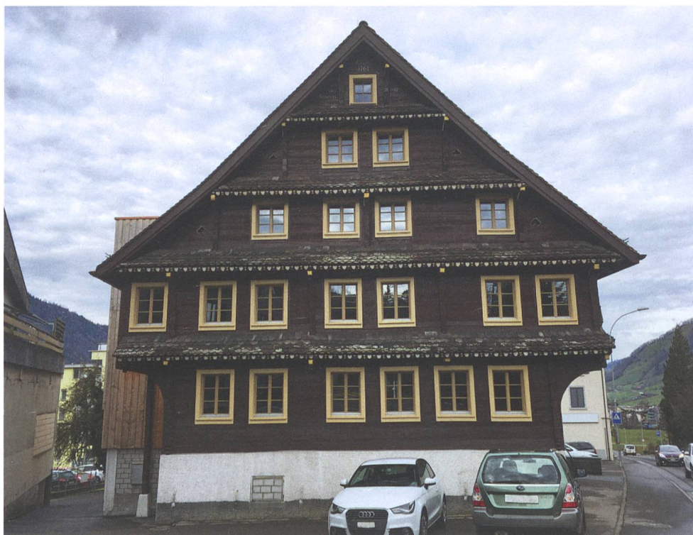
Abb. 5: Arth, Goldau, Gasthaus Bauernhof: Aussenaufnahme des stattlichen Blockbaus von Südosten.
