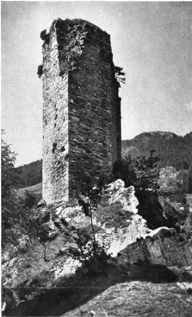
Der Turm von Santa Maria Calanca vor der Restaurierung. Der heruntergefallene obere Teil ist jetzt wieder aufgemauert.
