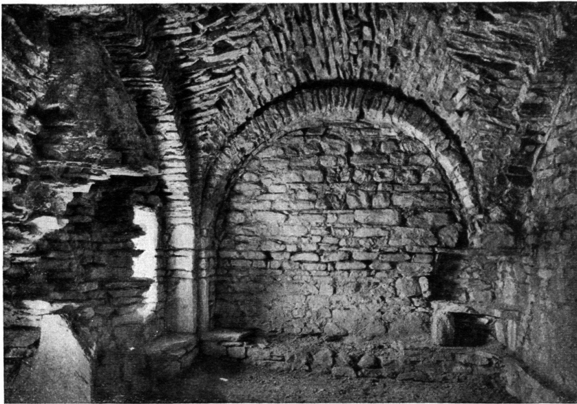
Turm von Santa Maria Calanca. Inneres des einen der beiden sich gleichenden Obergeschosse. Links Reste eines Kamins.
