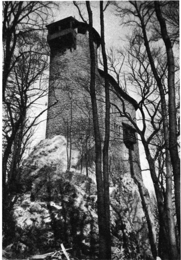
Reichenstein , wiederhergestellt, von der Bergseite (Osten)
