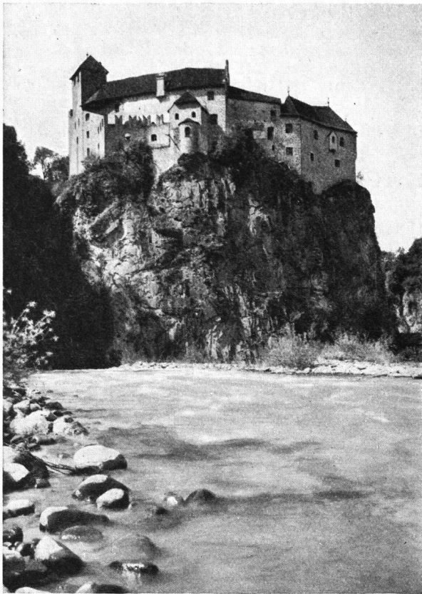
Runkelstein bei Bozen, wo die Burgenfahrer den zweiten Abend verbrachten.
