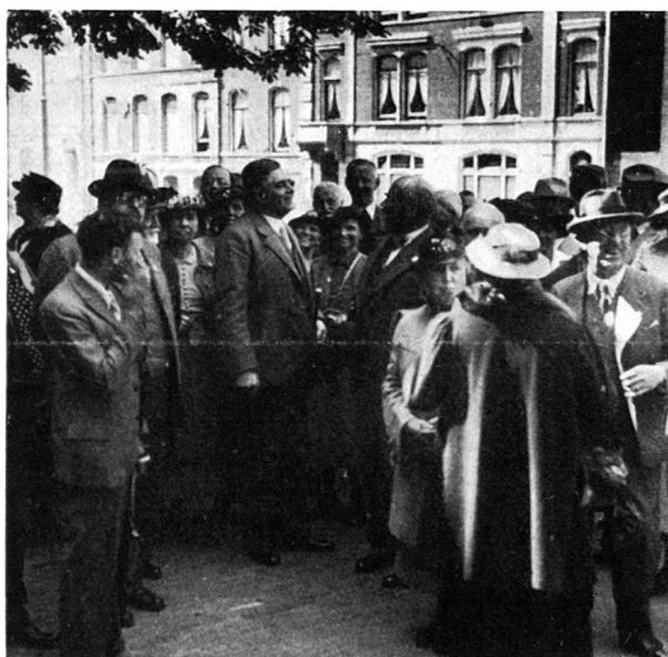
Architekt Prof. Slothouwer erzählt auf dem Domplatz in Utrecht von der Restaurierung des Domes
