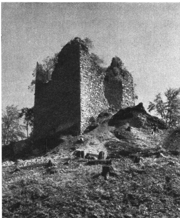
Montsalvens. Le donjon après le dégagement.
