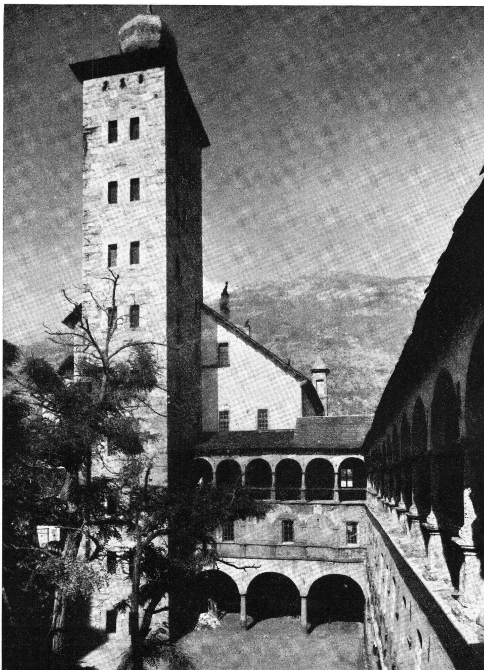
Treppenturm und Arkadenhof des Schlosses, Blick von Süden her
