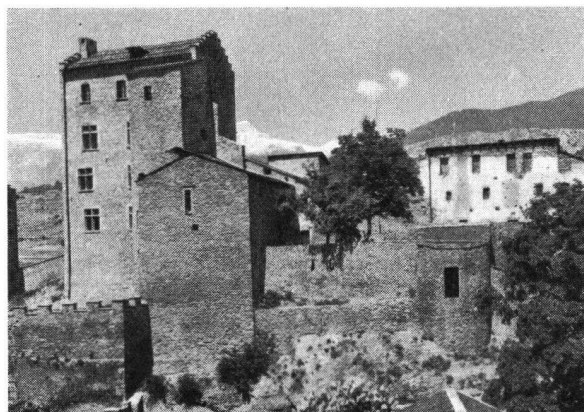
La Façade sud
