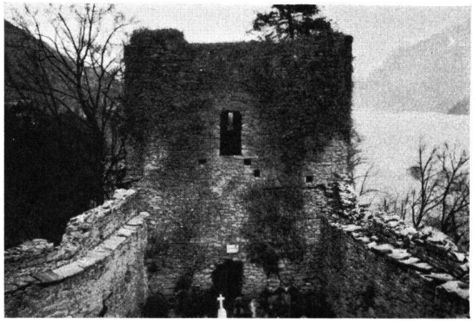
Wohnturm A nach Entfernung des Efeus. Man beachte den bloßgelegten Wehrgang der Ringmauern.
