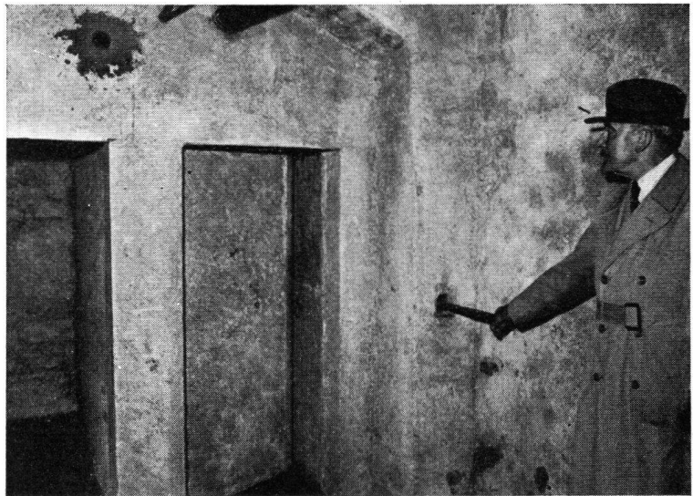
Blick im Raum 9 gegen die 2 Türen, rechts die geöffnete Steintür mit Verputzspuren und rechts davon der herausgezogene, lange Wandriegel zum Verschluß der letzten Steintür zwischen Raum 11 (am Ende bei der Wolfsgrube) und Raum 12, die beim Aufdrücken die Türöffnung zum letzten Raum 14 verschließt.
