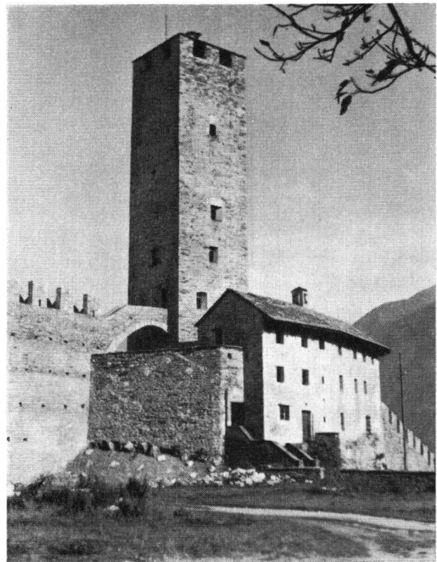
Nach der Renovation
