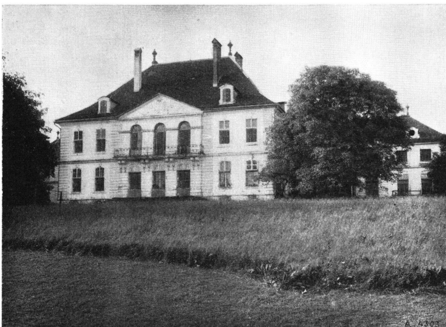
Schloß Hindelbank, Nordfassade
