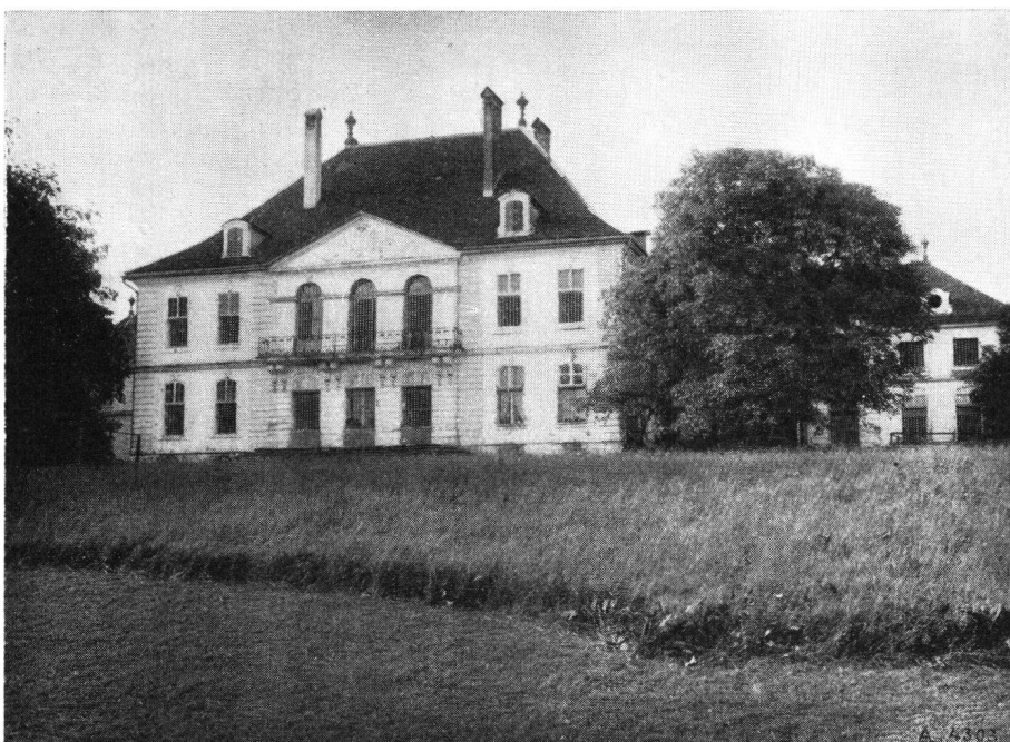
Schloß Hindelbank, Nordfassade
