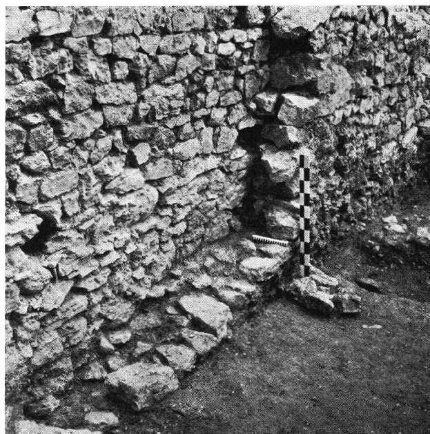
Freihof Löwenburg. Nördliche Wehrmauer, Ansicht von SW. Übergang vom dicken zum dünnen Mauerteil
