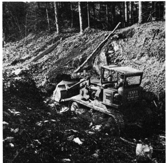
Aushub des Schuttes im Halsgraben mittels eines Traxes.
