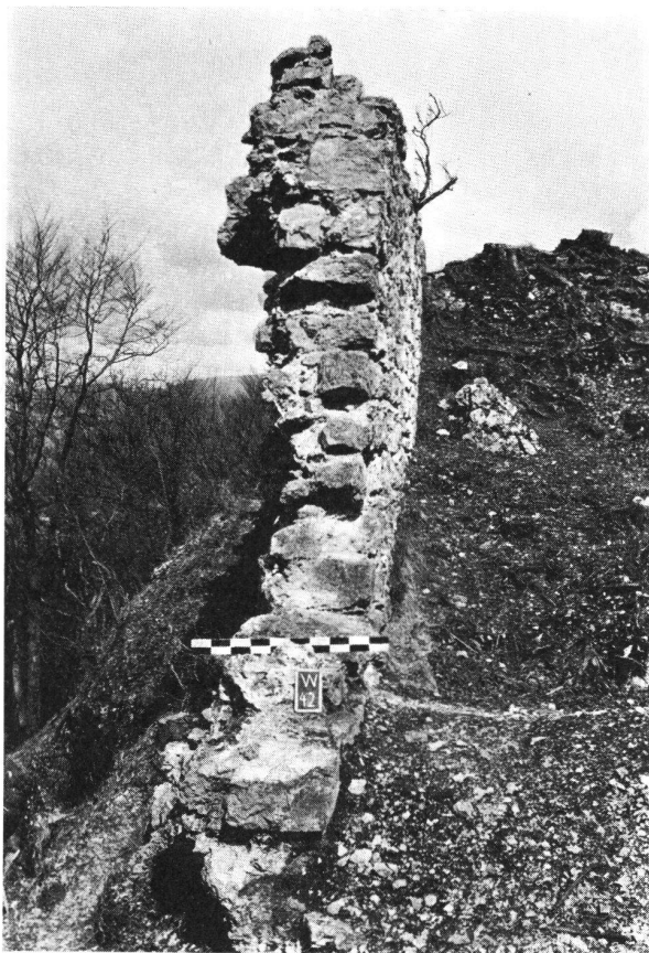
Abb. 2 Wartburg, westliche Umfassungsmauer.
