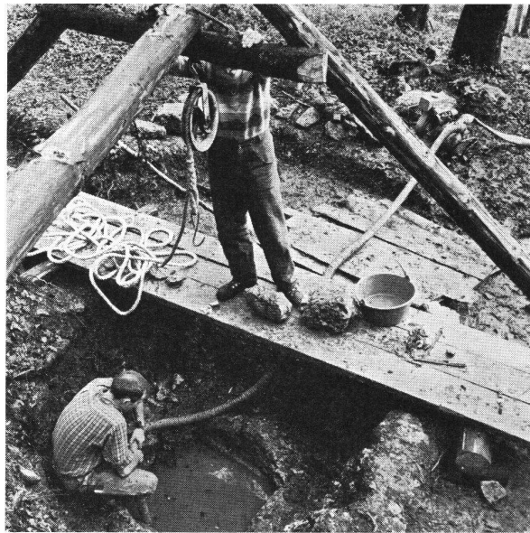
Abb. 6 Wartburg, Zone V, Auspumpen des Sodes.
