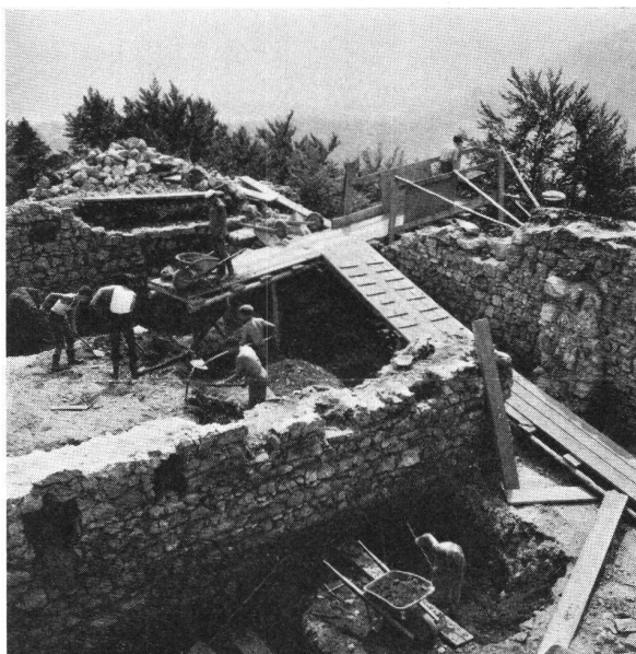
Wartburg, Aushub der Schuttmassen.
