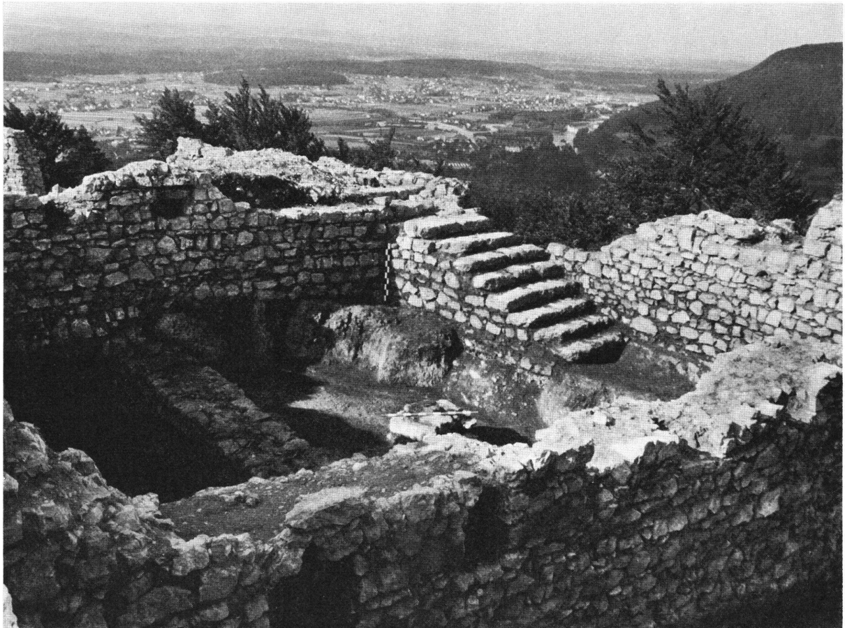
Wartburg, Südteil des Wohnturmes von Nordosten mit Kellerterrasse.
