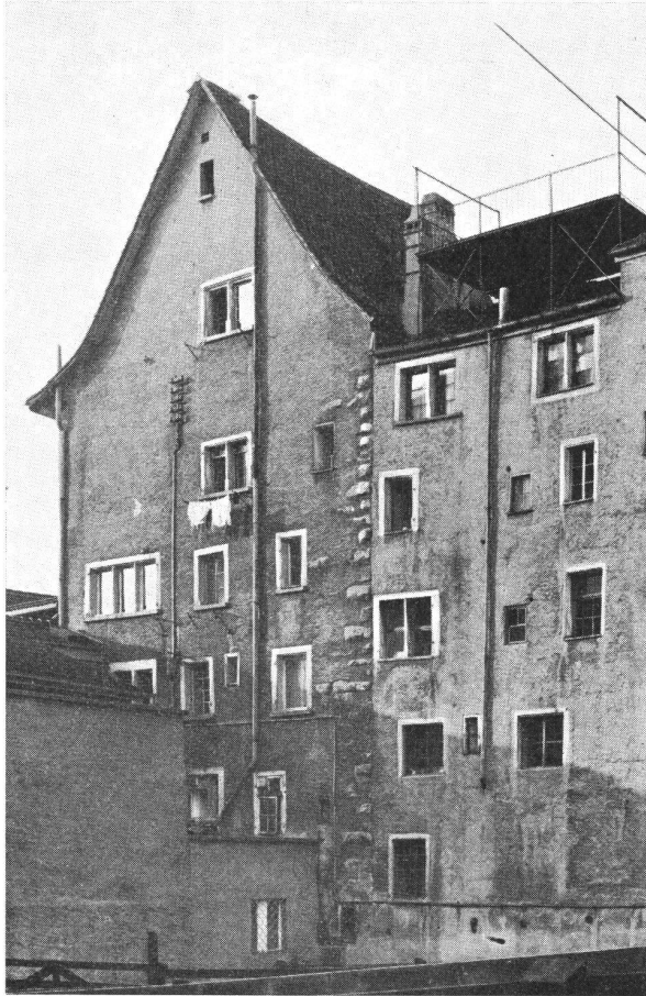
Zürich Glentner- oder Biberlirturm an der Rosengasse. Diese Aufnahme veranschaulicht uns das Beispiel eines ehemaligen Adelsturmes, wie er im Verlaufe der Jahrhunderte zum großstädtischen Miethaus degradiert wurde. Mit Ausnahme der Eckquadern erinnert uns nichts mehr an sein einstiges wehrhaftes Aussehen.
