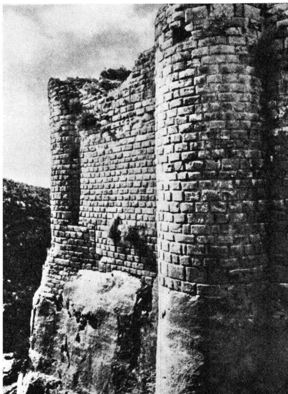
Kreuzfahrerburg des frühen 12. Jahrhunderts in Syrien. Typisches Beispiel eines Buckelquaderbauwerkes im Vorderen Orient, dessen Grundriß (Flankentürme) in weiten Teilen des Abendlandes Verwendung fand.
