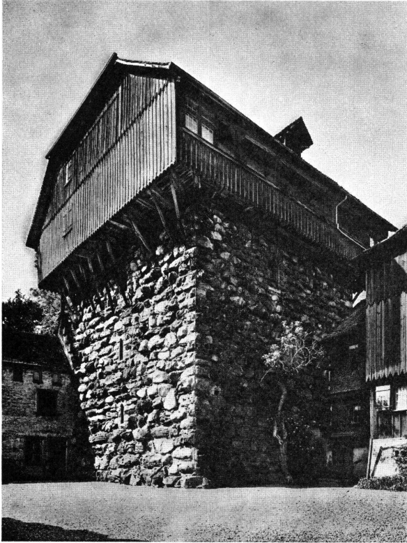
Mammertshofen TG. Burg. Sehr gut erhaltener Megalith-turm mit Obergaden, erbaut im 11. Jahrhundert. Seine Mauerstärke beträgt 3 Meter. Eines der schönsten Beispiele in der Schweiz.
