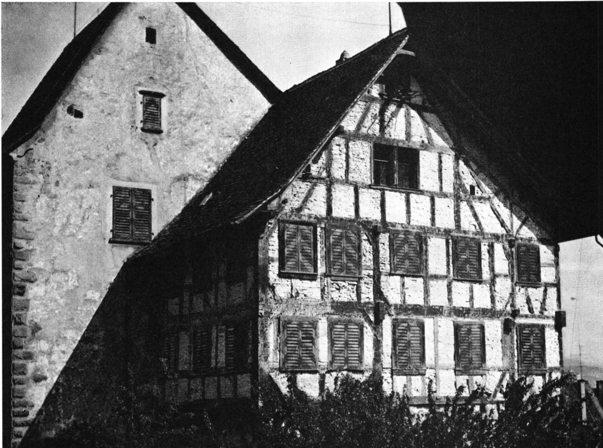
Zug Burg. Ostfassade. Turm mit zweitem, angebautem Wohngebäude in Riegelbauweise. Man beachte links die Bossenquaderung an der Turmkante.
