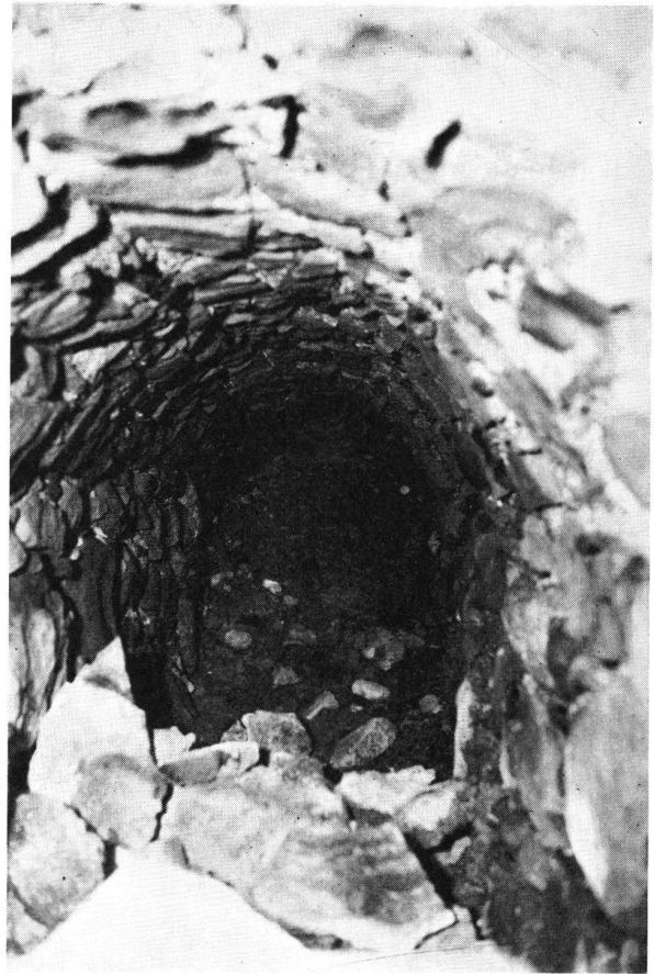
Rapperswil SG Unterirdischer Gang. Teilstück in der Nähe des Rathauses. Aufnahme vom 12. Oktober 1938.
