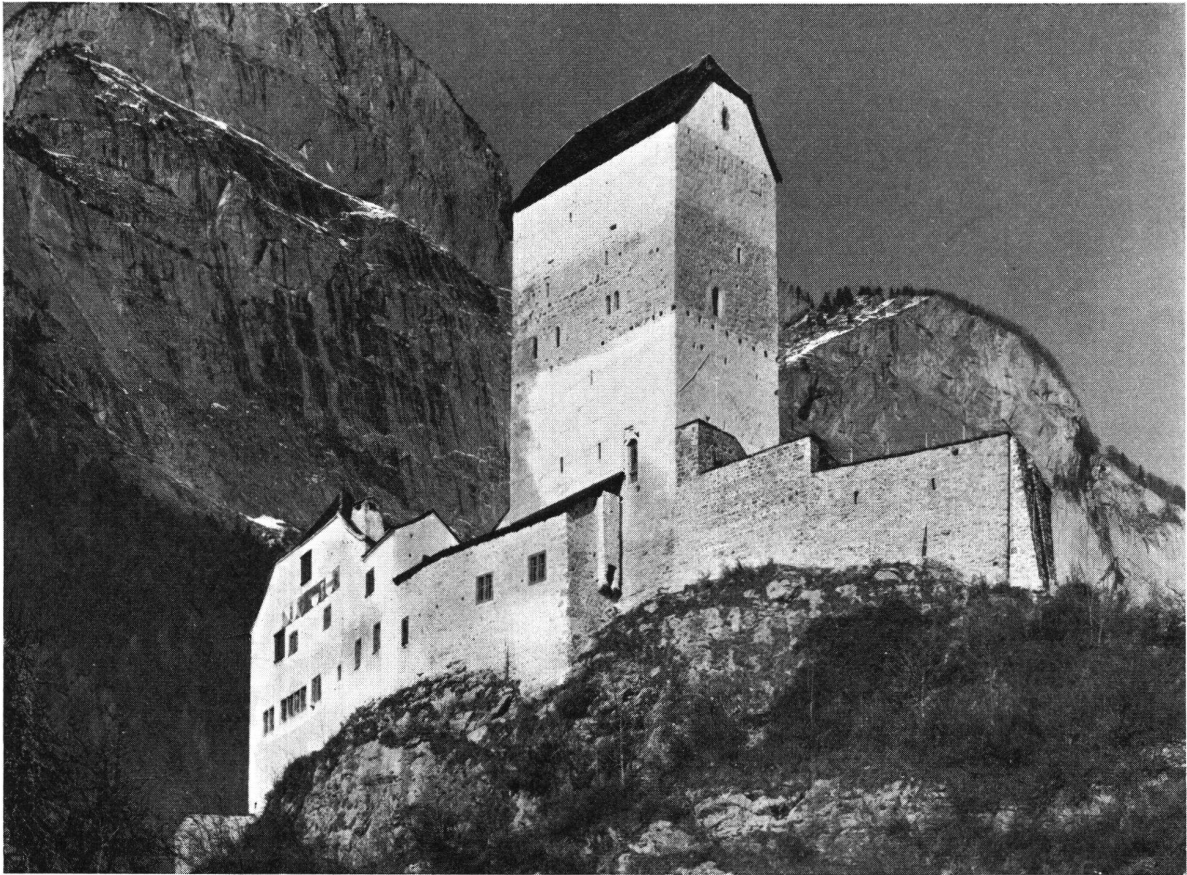
Der Bergfried des Schlosses Sargans nach der Restaurierung von 1969/70. Die Mauerabschnitte und Verputzzonen sind deutlich erkennbar.
