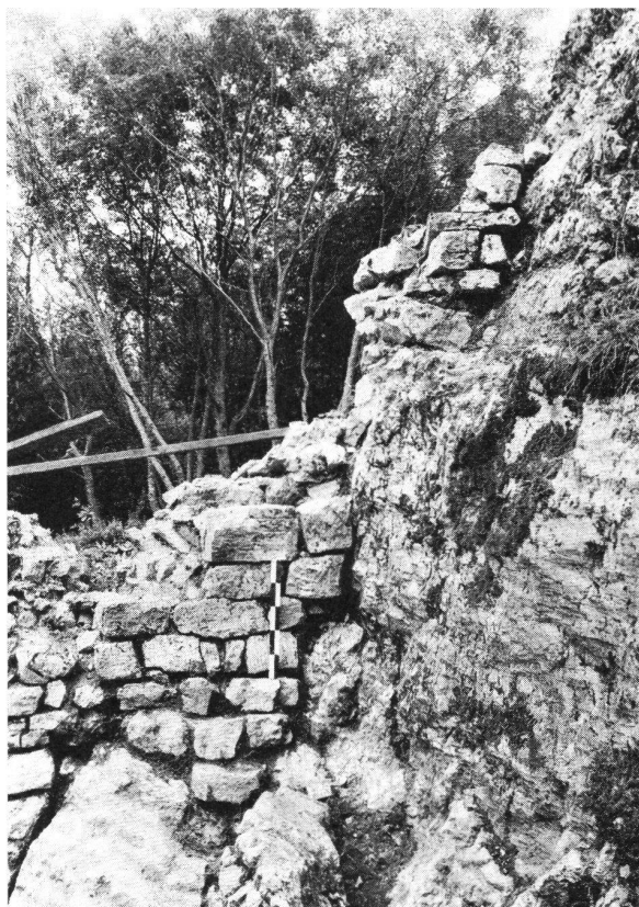
Frohburg. Reste der südlichen Ringmauer, freigelegt 1973. Das ausgezeichnete Quadermauerwerk ruht direkt auf dem Fels auf.
